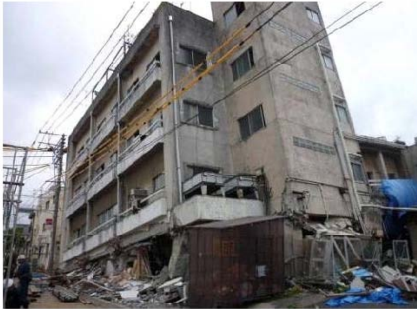
写真 5. 2. 1-1 1階の層崩壊
