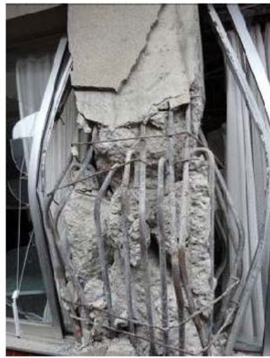
(b) 上筋段落とし部を 起点とするせん断破壊
