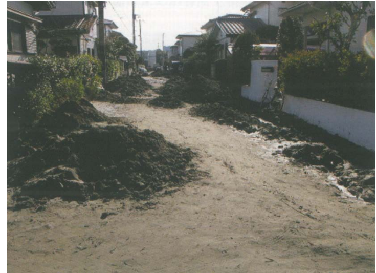
住宅街における大量の噴砂(千葉県) 「2011年東北地方太平洋沖地震災害調査速報」(日本建築学会)より
