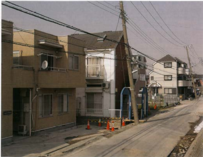
液状化による電柱の傾斜。道路の起伏発生(浦安市) 「覆る建築の常識」(日経アーキテクチャ編)より
