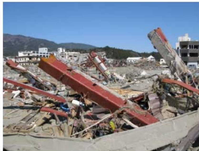
写真 6. 4. 2-3 根巻柱脚の1階柱の残存（陸前高田市） 写真 6. 4. 2-4 1階柱の残存（陸前高田市）
