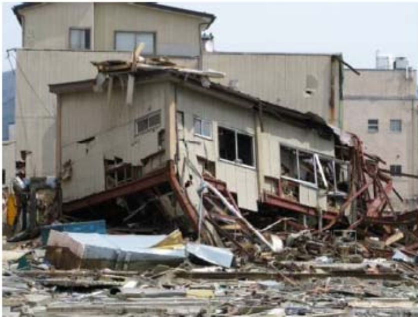
写真 6. 4. 2-10 2階建てS造の1階の崩壊（大船渡市）
