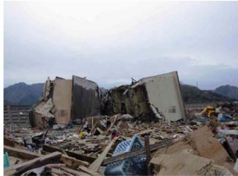
写真 6. 4. 1-8 集合住宅の転倒(CB造)
