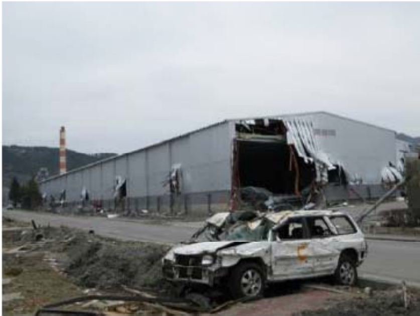
写真 6. 4. 2-24 倉庫（大船渡市）
