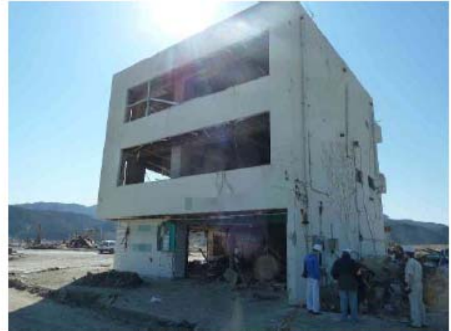
写真 6. 4. 1-2 残存する3階建て建築物
