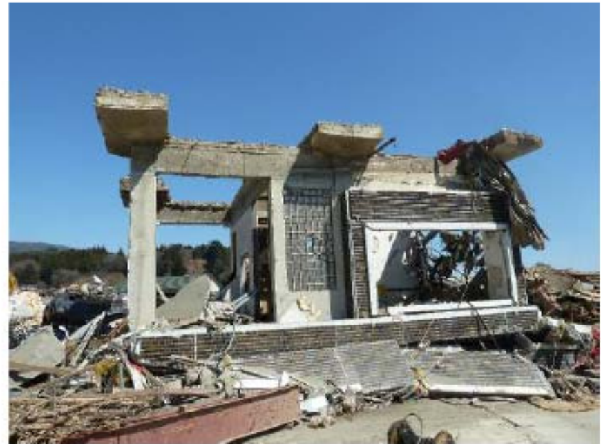
写真 6. 4. 1-4 上下逆さまになった2階建て建築物
