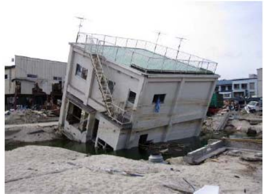
写真 6. 4. 1-10 洗掘による2階建て建築物の傾斜
