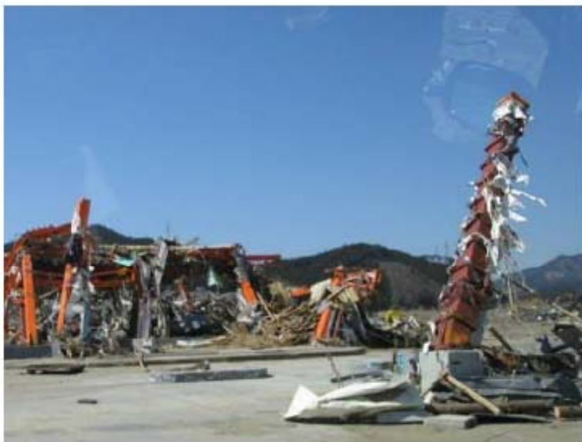
写真 6. 4. 2-3 根巻柱脚の1階柱の残存（陸前高田市） 写真 6. 4. 2-4 1階柱の残存（陸前高田市）
