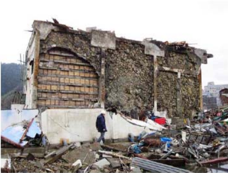
写真 6. 4. 1-7 塀を乗り越えた2階建て建築物
