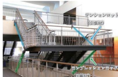
図-5 吹抜け部のトラス階段
