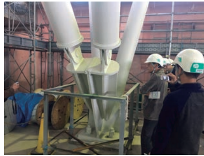
屋根トラス梁の柱脚部
