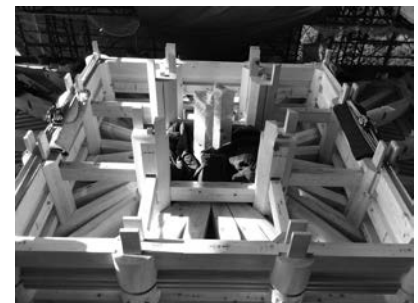
写真3 四重施工状況
