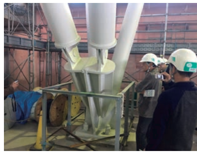
屋根トラス梁の柱脚部
