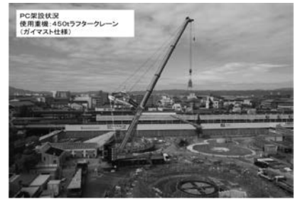
写真4 ガイマスト仕様の揚重機
