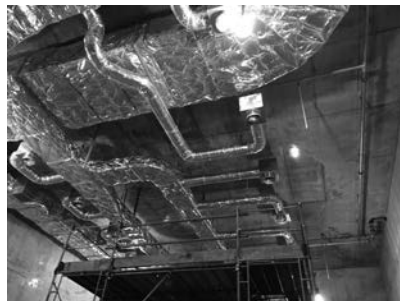
写真1 TWFS構造の天井
