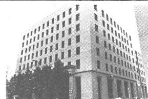
ている。時あたかも、サンフランシスコ地震（1906）や関東大地震（1923）などによって、組積造の弱点がようやく認識され、それまで主流を占めていた煉瓦構造から鉄筋コンクリート構造への移行期に当たっている。この時代を反映して、新しい技術を積極的に導入した部材と旧態の形式を墨守した部分とが混交している。部材としては、1階の吹抜け部分に当時としては珍らしい鉄骨鉄筋コンクリート造を採用し、その鉄骨は8Ls-4'×4'×0.6'（インチサイズ）となっている。また耐震壁は煉瓦一枚半積で構成している。しかし、竣工前年に関東大地震が発生し、翌1924年に市街地建築物法が改正され、煉瓦の構造壁体への使用が禁止されたため、この種構造形式の最後の建物に該当する。この煉瓦壁体
