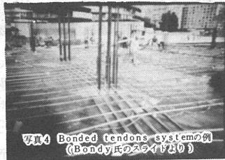
隔とするがそれと直交する方向は、そのPC鋼材を集約して柱から柱に架け渡した形で配線するもので、設計上はこの部分に仮想のはりがあるものとしてその直交方向を一方向スラブとする。この場合柱の配列は必ずしも一直線上にある必要はなく、配列の多少の乱れは柱の列を結ぶように曲線状に配置してやればよい。すなわちこの方法によると、i) 柱の配列が不規則であっても対応しやすく、ii) スラブに開口が設けやすい、等の利点が得られる。なお、この集約配置方式と普通の分散配置方式との力学上の差異等について、数年前からテキサス大学で実大実験による検討が行われており、終局域でのひびわれ発生パターンなど両方式とも大差ないことが明らかにされているとのことであった。今後わが国でも検討し、採り入れてよい方法であろう。
