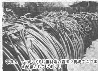
耐久性、したがってアンボンド鋼材の腐食性に関するアメリカ内の認識には違いが見られ、環境条件のよい内陸部で主に仕事をしている人々はこれまでに鋼材の腐食破断の例を聞いていないため余り気にしていないようである。しかし、海岸近くなど環境条件の悪い所では、特に鋼材定着部で腐食破断の例もあり、またそれに近い状態になっているものがあるので、防食対策には充分留意する必要があるという強い意見が、ホノルルのYee氏から示された。同氏はわれわれ日本人にはスリーヴジョイント工法やPCのバーチ、海洋構造物などで馴染みであるが、悪い環境条件下にある建物ではその対策として主要部のPC鋼材にはグラウトを施工する方針とし、アンボンド鋼材を用いる場合は定着部のシースの被覆を完全にすることはもちろんあるが、定着部の隙間に樹脂を注入し、さらに外側にモルタルカバーを施して水分の侵入を防ぎ安全を期しているとのことであった。
