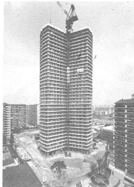
高い剛性で風による揺れに対処し、大変形時には、ねばりのある靱性を保有する事で地震等に対処している。又、下層部柱には、F C 360 kg/cm<sup>2</sup>の高強度コンクリートを用い、内蔵する鉄骨は、圧延H型鋼を使用している。1次固有周期は、2.7秒であり、Y型のねじりによる影響は、ほとんど無い。応答結果は、EL CENTROが最も大きく、X方向、Y方向共にほとんど差は見られない。応答結果の最大ベースシア係数は、25Kine応答で0.104、40Kine応答で0.127、最大層間変形角は、それぞれ1/211、1/144である。
