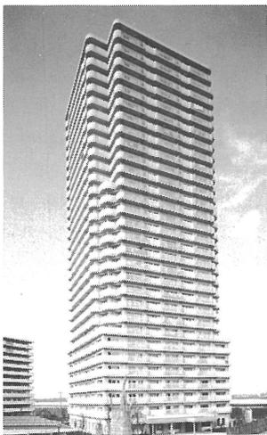
そのうち徐々に他の部所の支援が得られるようになり、高層RC造の設計ソフトの開発や、組立鉄筋工法、高強度コンクリートの調合、施工法、品質管理法などの研究を行いました。これらの成果により日本建築センターの構造評定を取得しましたが、残念ながらこの建物は実施に至りませんでした。しかしこの間に得た知見をもとに昭和62年の、今回のJSCA賞受賞の対象となりました「高見フローラルタウン七番街15号棟」の開発へと移行します。ここで新しく高強度コンクリート品質管理法を開発しました。この方法は水分計により骨材の表面水を測定し、その値によりコンクリートの単位水量を調整する方法です。この方法により施工された「高見フローラルタウン七番街15号棟」は安定した品質の高強度コンクリートを確保することができ、ご指導を受けた六車教授よりお褒めの言葉を戴きました。
