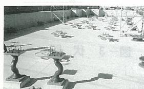
写真2 免震装置設置状況
