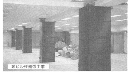
写真2 某ビル柱補強工事
