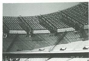
最終的には、独立柱と持ち出し梁によるL型の架構を新たに設け、屋根を支持する方法がとられている。柱、梁とも弦材、斜材にH型鋼を用いたトラスをBOX状に組み上げている。2日前にバーリで観たレンゾピアノ設計のサンニコラスタジアムの洗練された美しさが
