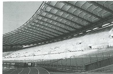
ウイングルーフフレームは、次の断面図に示すように、高さ10m程の外周三角形状立体S造トラスリングとウイング先端内周ワイヤロープリング間に、各々78
