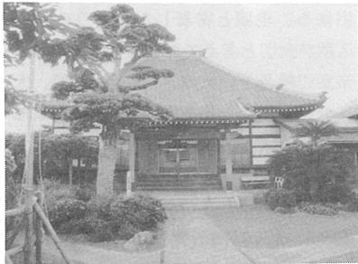
設計クライテリアは、まれ地震時で層間変形角1/100rad以下、ごくまれ地震時で1/30rad以下を目標とした。EL-CENTROの地震波形を用いて、まれ地震を100gal、ごくまれ地震を450galとして応答値を算出することとした。
