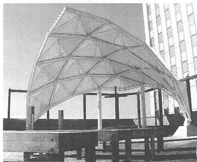
写真5 張力安定トラス構造の屋根
