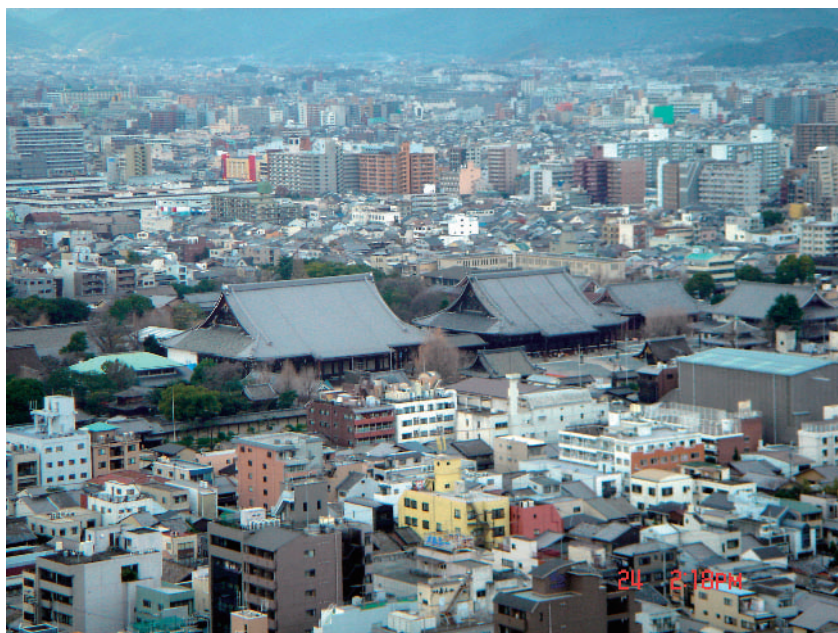
西本願寺御影堂 平成大修復
