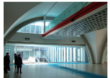
写真-3 B棟のブリッジ
