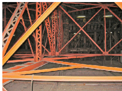
小屋裏トラス補強
