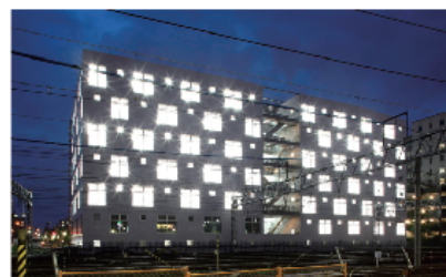
写真-2 竣工写真(夜景)
