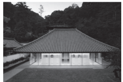
写1 参道からみたファサード
