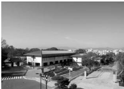
写真1 国宝三門より見た和順会館と参道
