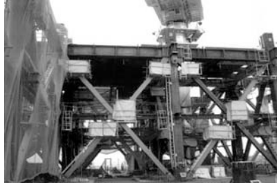
写真1 防風対策の実例
