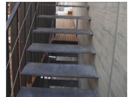
写真6 RC壁から突き出した鉄骨階段
