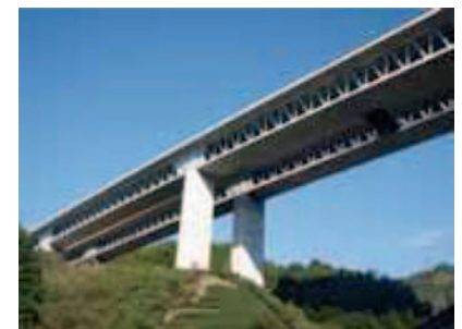
第二東名猿田川橋・巴川橋・鋼トラスウェブPC橋
