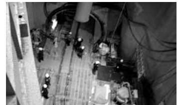
写真3 難波元町発進立坑（見下げ）
