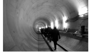
写真4 御堂筋共同溝
