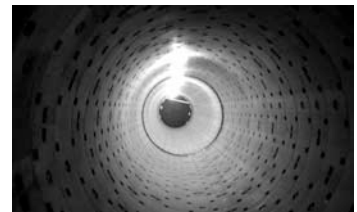
写真6 分岐立坑（見上げ）
