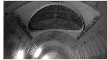
写真5 上向きシールド発進坑口
