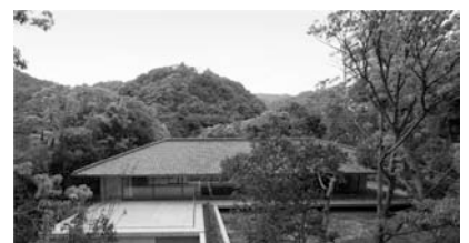
図6 竣工写真（外観）
