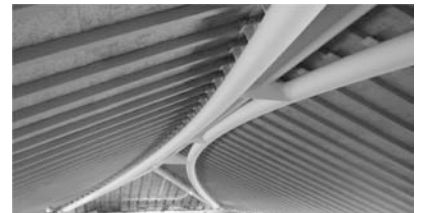
図5 屋根架構の鉄骨建方完了写真
