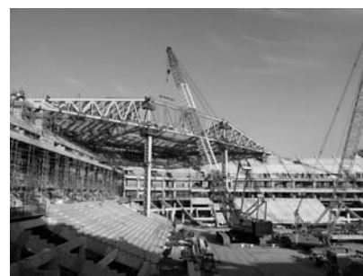
鉄骨屋根架設状況
