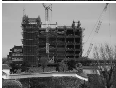
素屋根鉄骨解体状況
