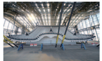
修理後 五重屋根
