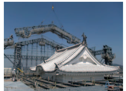
屋根合掌鉄骨解体状況
