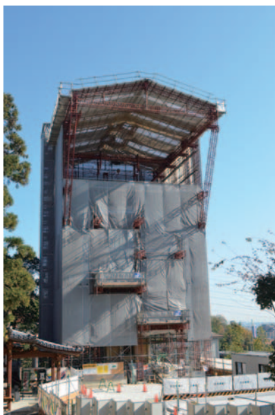
【素屋根の様子】
