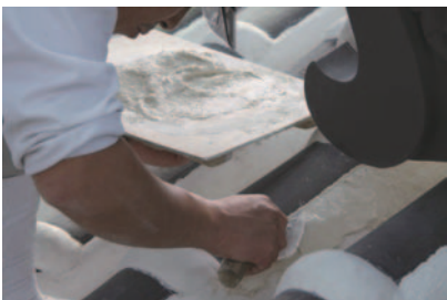
瓦目地漆喰上塗り状況
