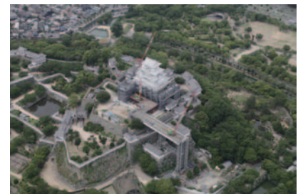
空撮による平成の保存修理工事の全容
