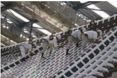
五重屋根瓦目地漆喰塗状況
