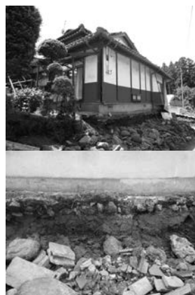
図4 建物基礎下の表層土の状態
