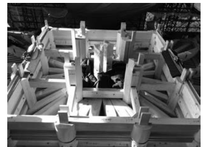
写真3 四重施工状況
