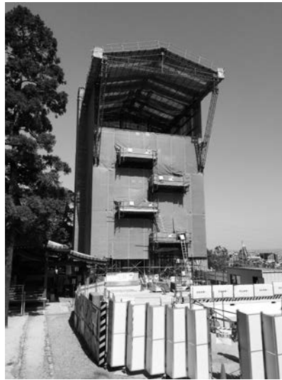
写真1 中山寺五重塔素屋根全景
