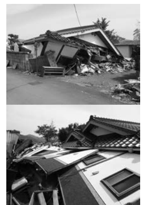
図5 瞬発的に倒壊したとみられる民家
