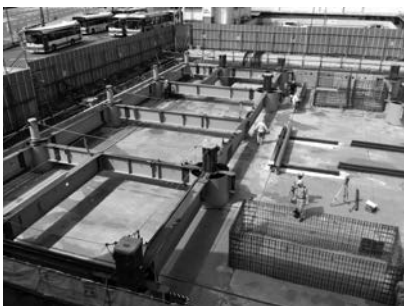
写真2 基礎工事状況
