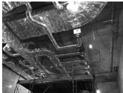
写真1 TWFS構造の天井
