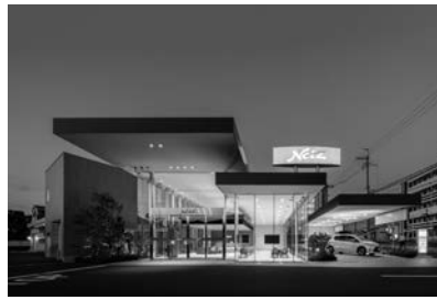
写真1 外観（建物入口側より）
