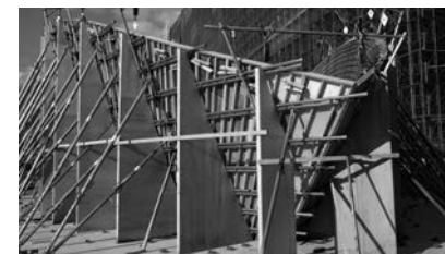
写真3 型枠施工
