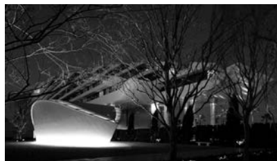
写真1 外観写真(手前:チャペル)
