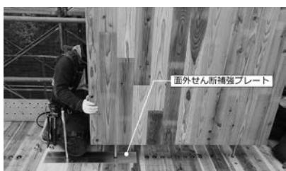
図5 面外せん断補強プレート施工状況
