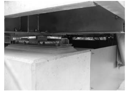
写真4 傾斜すべり支承の設置状況
