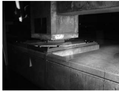
写真2 剛すべり支承の設置状況
