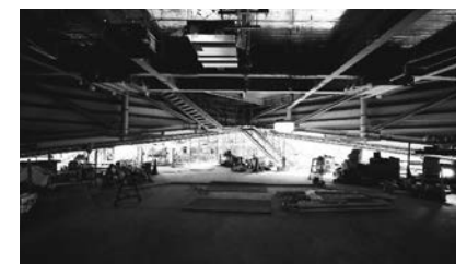
図4 内観写真(ジャッキダウン後)
