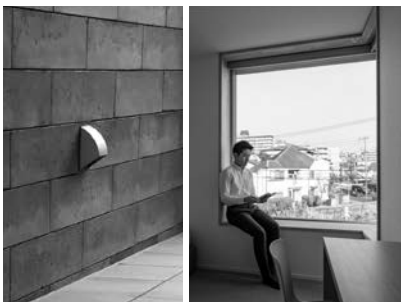
写真3 設備開口 写真4 寮室の大開口
