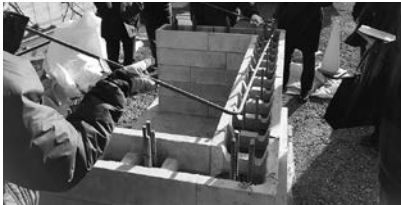
写真2 RM造施工風景
