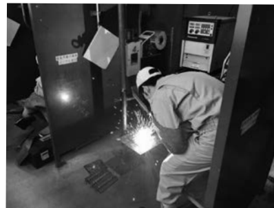
写真4 半自動溶接の実技状況
