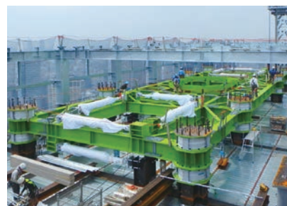
写真2 TMD施工状況
