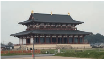
写真1 復元された大極殿(遠景)
