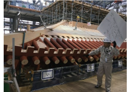
写真5 現場所長による現場説明
