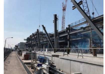
図3 現場建方の様子
