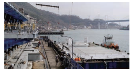
図5 鋼板外装の海上輸送の様子
