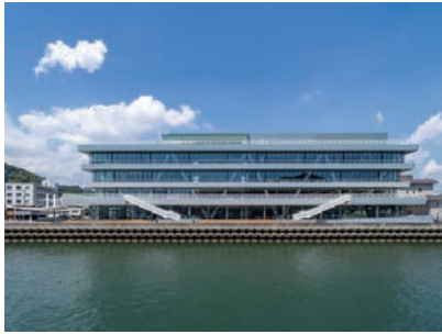
図1 南側立面写真(尾道水道より)
