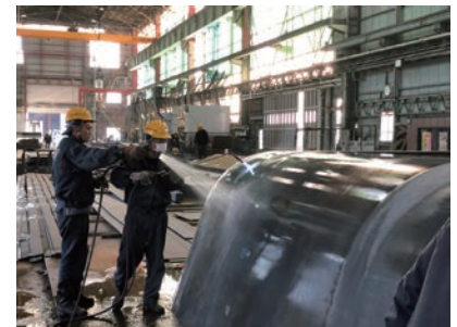
図4 鋼板外装のぎょう鉄の様子
