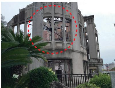
第4回では、芸予地震を想定した地震対策として3箇所の壁に補強鉄骨を追加しています。原爆ドームを補強の観点から見るのも興味深いものと思います。
