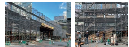
写真3 空中歩廊道路上部 歩廊アーチ梁脚部
