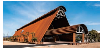
鋼矢板を構造とする建物(技研製作所HPより)
