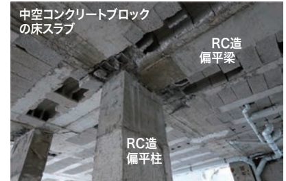
写真3 ジョイストスラブ形式の架構
