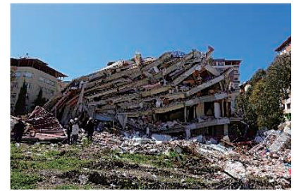
写真2 パンケーキ状破壊した建物
