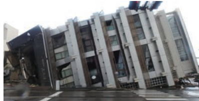
写真1 転倒した7階建RC造建物(輪島市)
