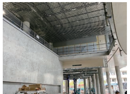
1階エントランス吹抜(左が打放し壁)
