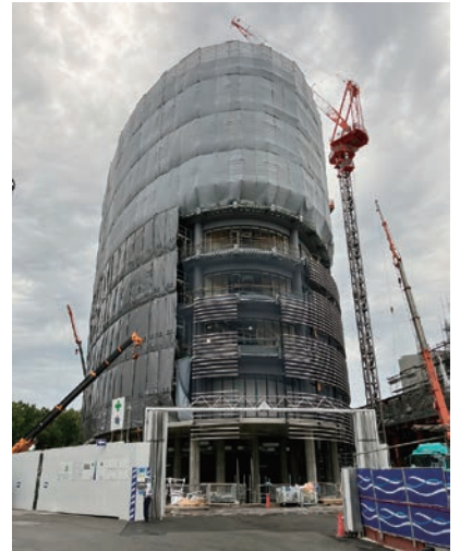
施工状況(建物北面より)
