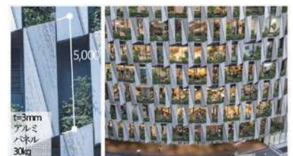
写真2 低層部グリーンファサード
