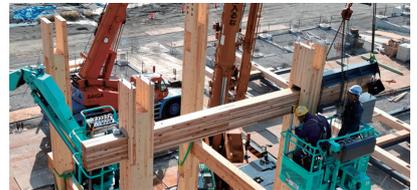
写真4 南東工区の貫梁取付状況
