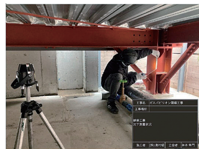
図6 沈下計測状況
