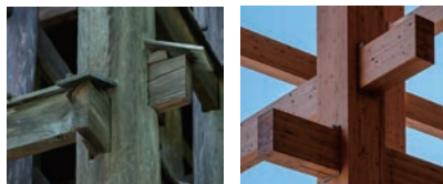
写真2 ボルト等の見えない貫 (左:清水寺、右:西工区)
