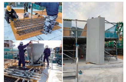
写真4 斜め壁PCaの製作状況
