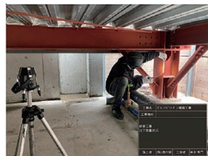
図6 沈下計測状況
