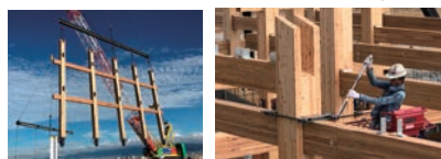
写真3 西工区 施工状況
