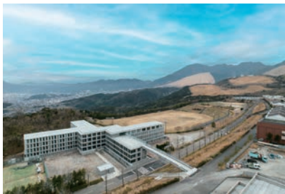
写真1 建物の鳥瞰写真
