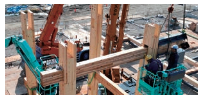
写真4 南東工区の貫梁取付状況
