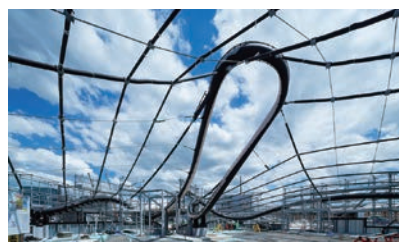
図6 施工写真(ケーブル緊張時内部)
