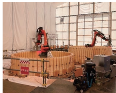
写真2 3Dプリンターによる施工状況
